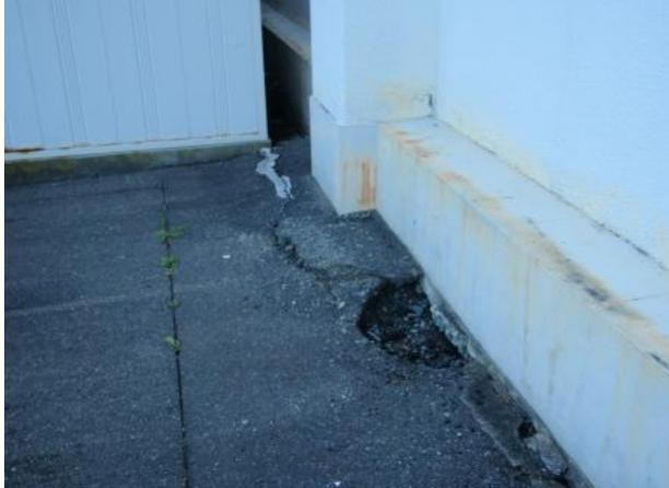
①着工前 地盤沈下のため、地下の排水管が破損した
