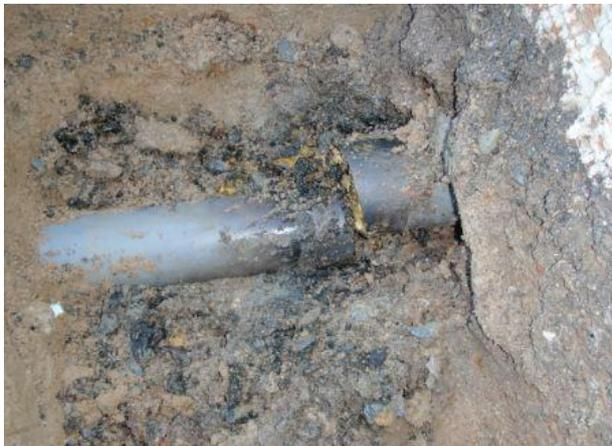
③トイレ排水管破損状況(汚物があふれている)
