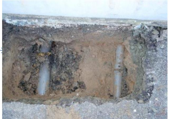
②破損したトイレ排水管
