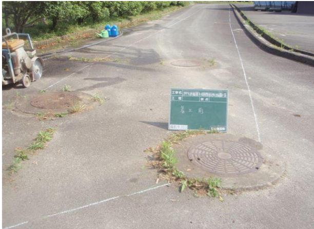
①着工前 地盤沈下のため、人孔柵が下がり、排水ができなくなっていた
