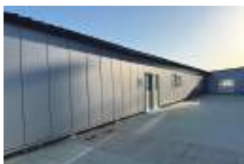
壁全面を断熱仕様へ改修
