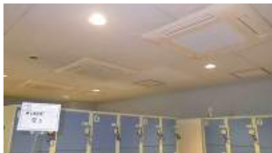
空調設備更新
