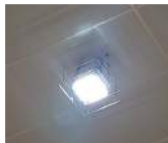
体育館照明LED化
