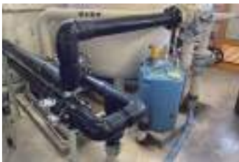
ろ過機配管改修工事
