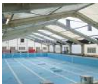
プール照明LED化
