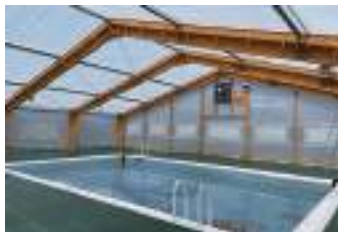
シート取替工事
