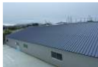
上屋を断熱仕様へ改修
