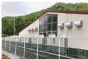
プールチラー更新工事
