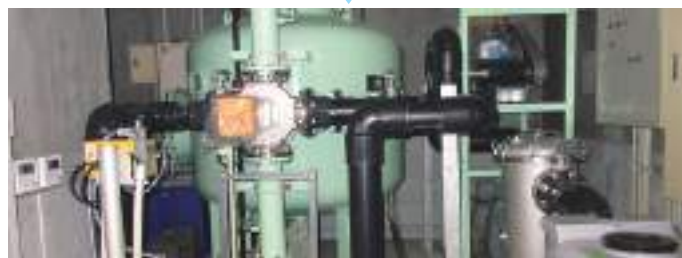
高分子ろ過装置への取替工事
