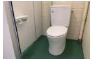
更衣室トイレ改修工事
