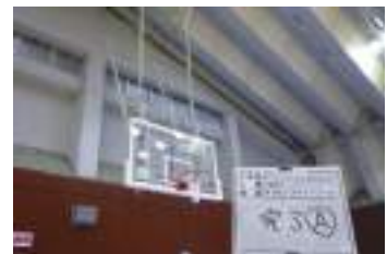
バスケットゴール更新工事
