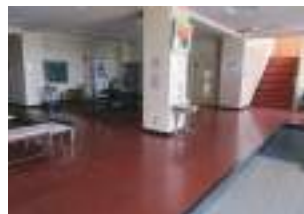
エントランス・ロビー修繕
