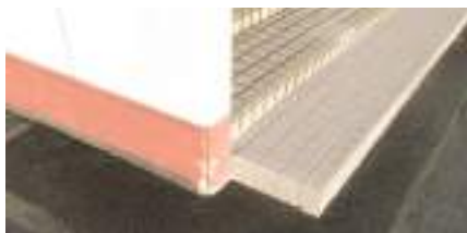
地盤沈下補修
