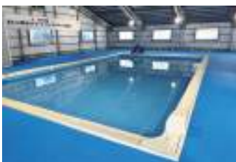
プールサイドの改修
