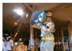
手作業による溶接工程
