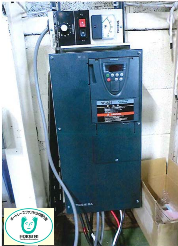
写真 4. 1. 4-7 負荷機用インバータ (これにより負荷機のポンプ回転数を調整する)
