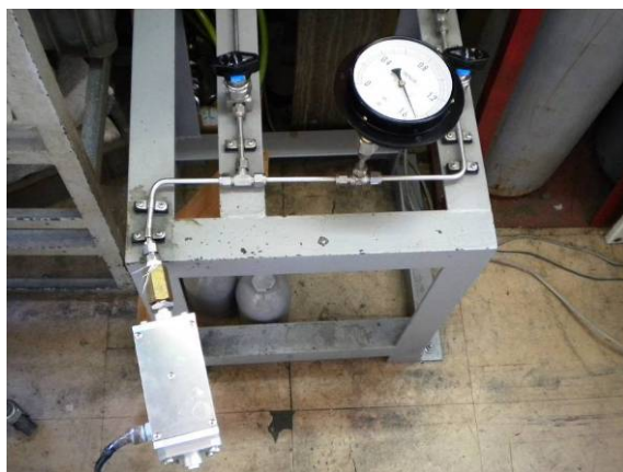
図 4.2.13 耐圧試験全景
