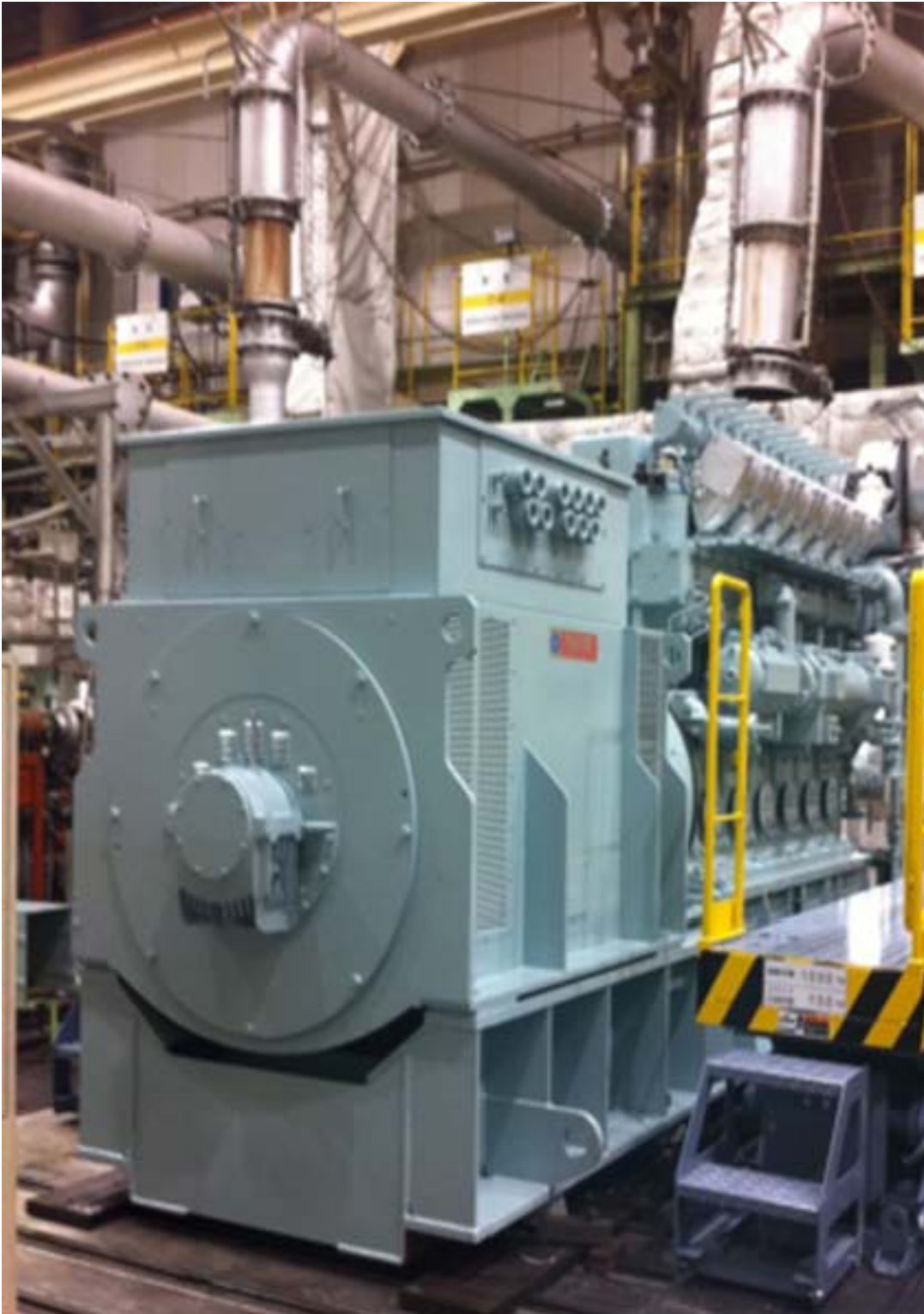
6 気筒ガスエンジンの据付状況
