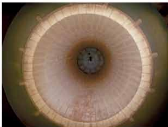
図 8.4.6 昇温バーナー内部
