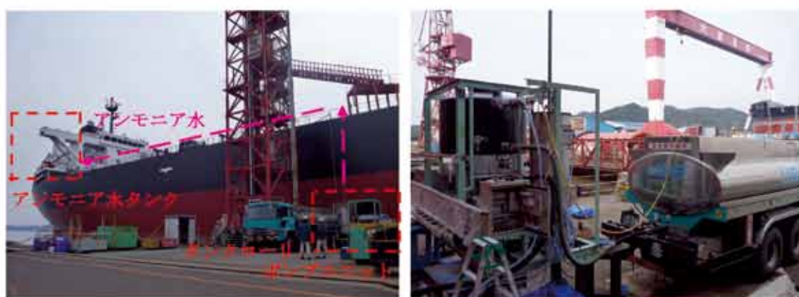
図 6.2.3.1 アンモニア水搭載作業
