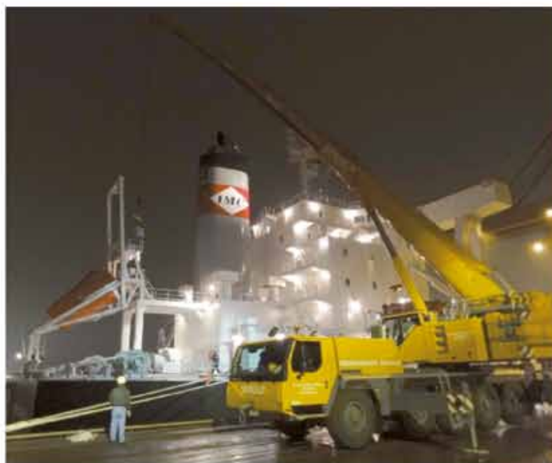
図3-23 陸上クレーン車による尿素水タンク運搬状況
