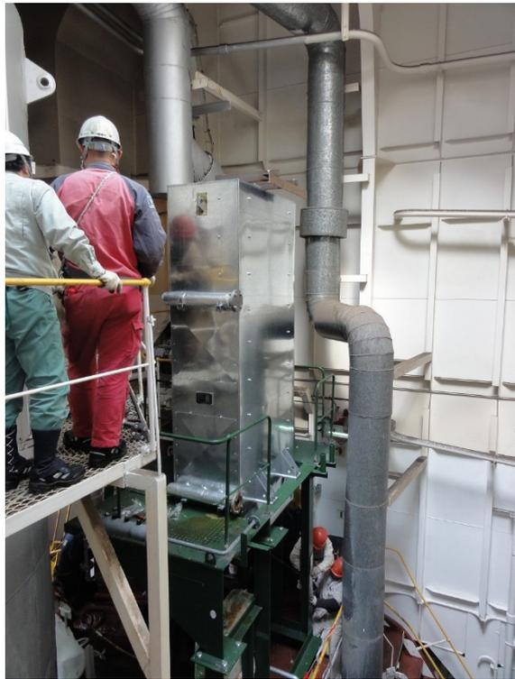
図57 排熱回収型サイレンサ設置
