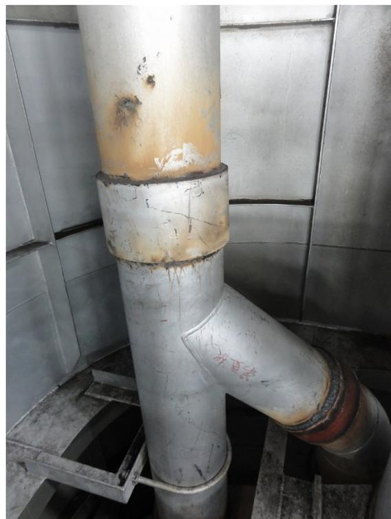
図60 排ガス管上部改造部
