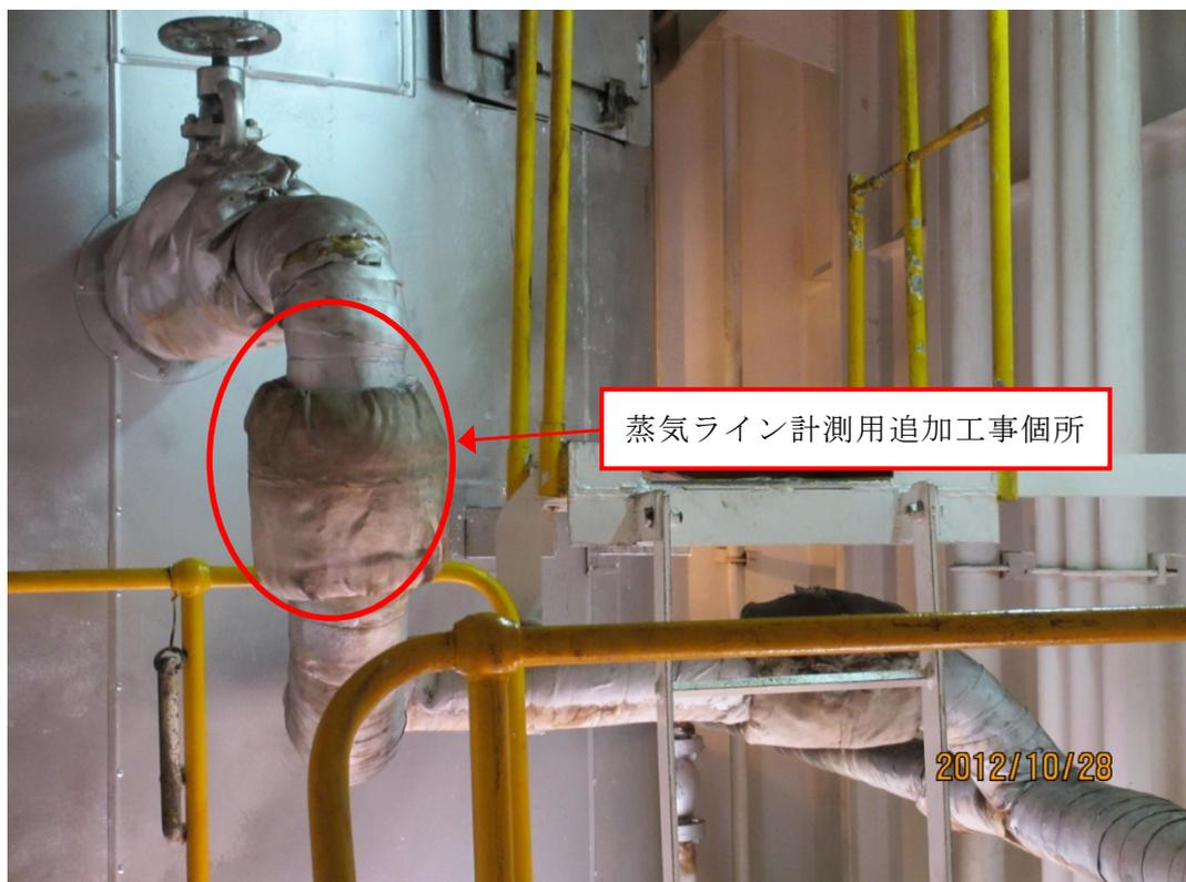
図4 ボイラ(蒸気ライン工事箇所)
