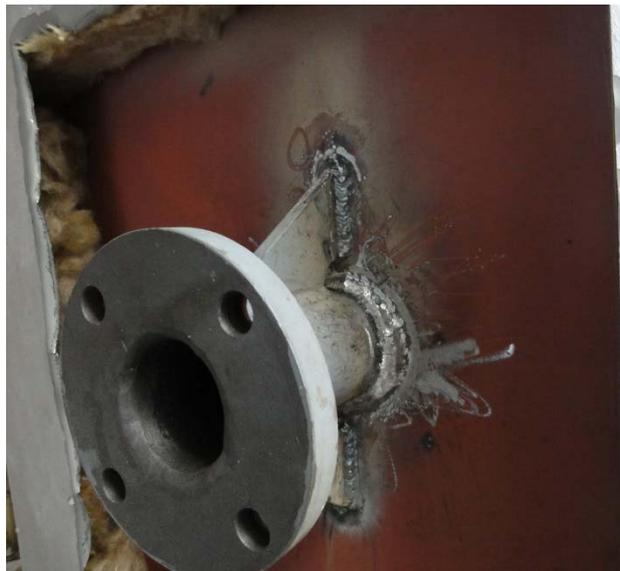
図58 ボイラ改造（溶接工事：循環水取出し配管）
