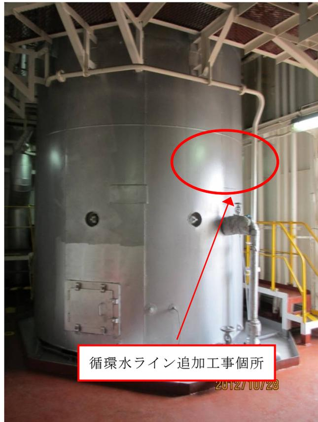
図3 ボイラ(循環水ライン追加箇所)
