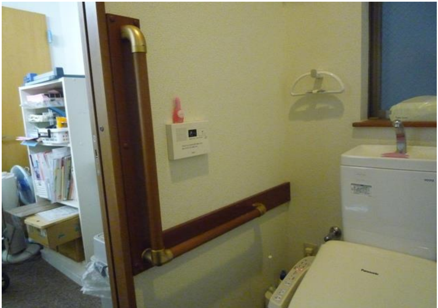
ステーション事務所の車椅子可能トイレ:手摺り設置
