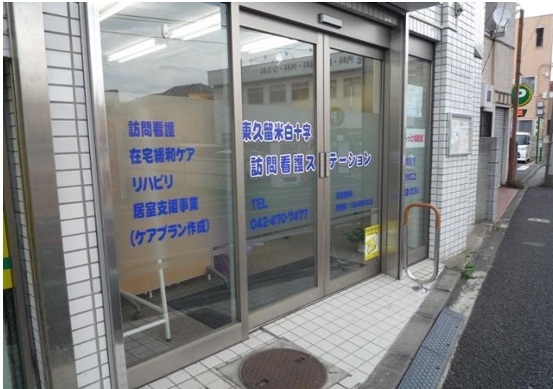
入口：手摺り設置、段差解消
