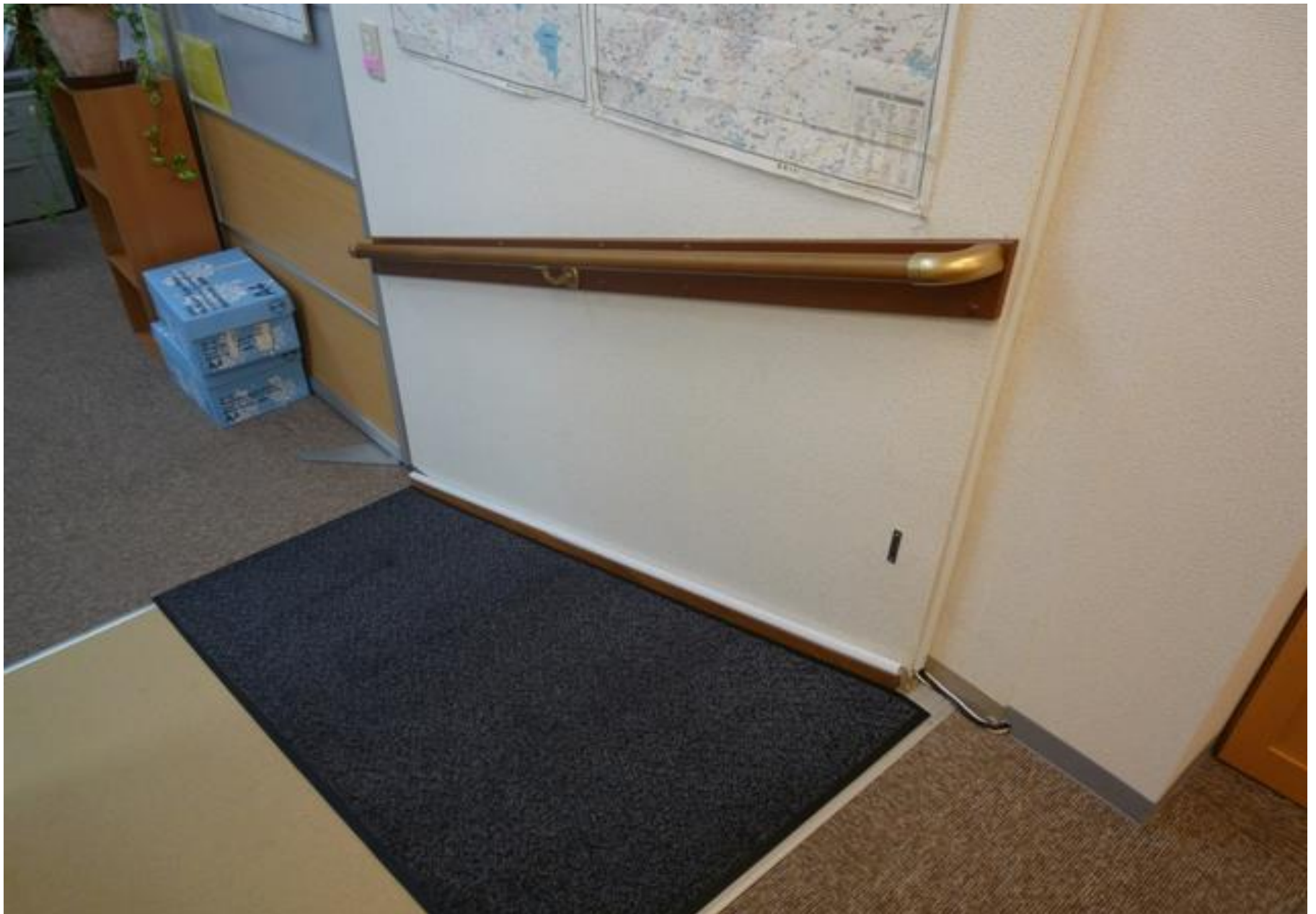
相談室からステーション事務所トイレにおけるスロープ：手摺り設置
