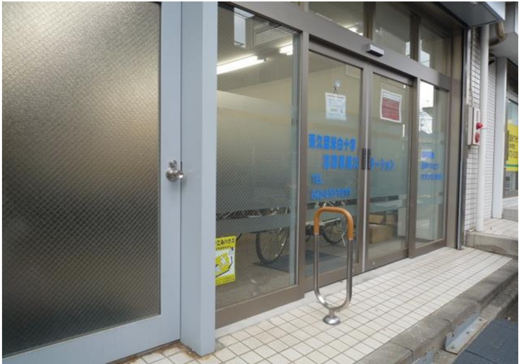
裏側入口：手摺り設置
