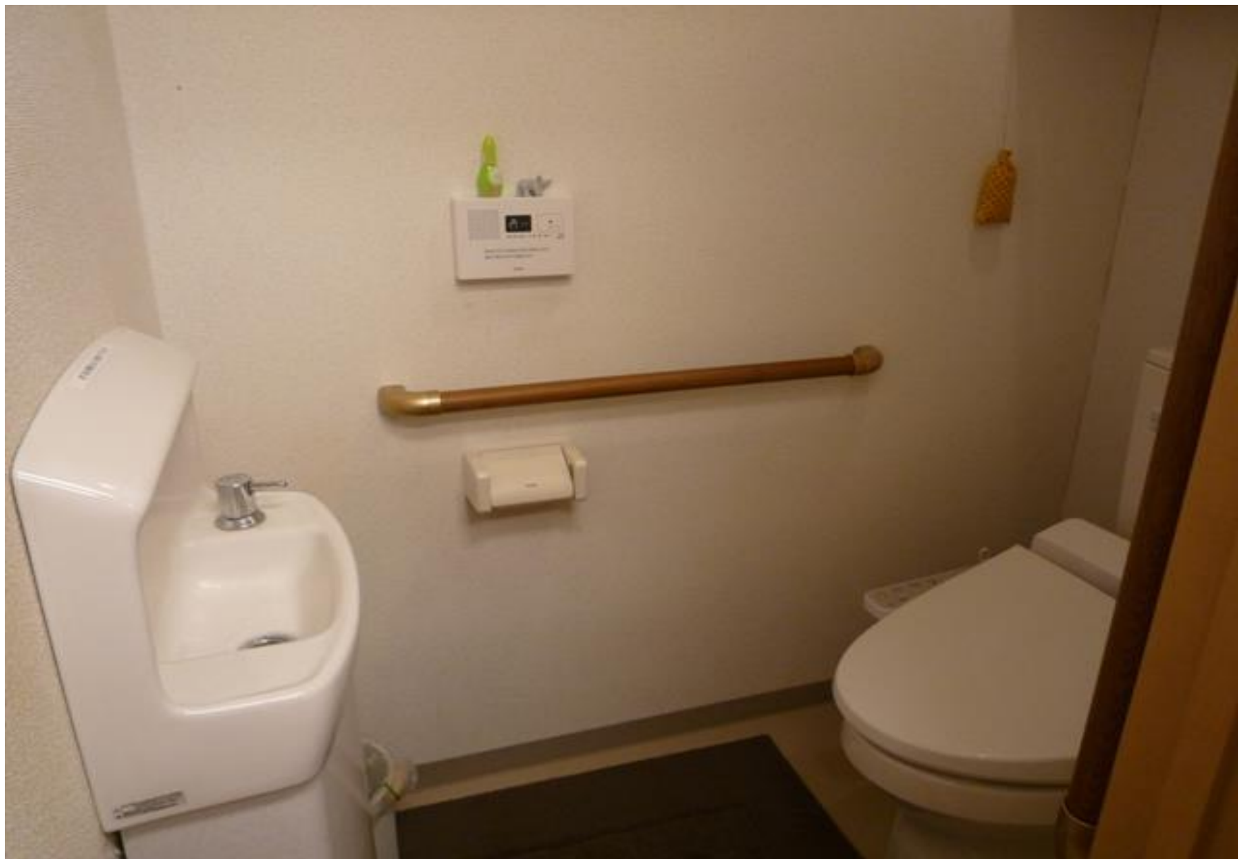
トイレ：手摺り設置
