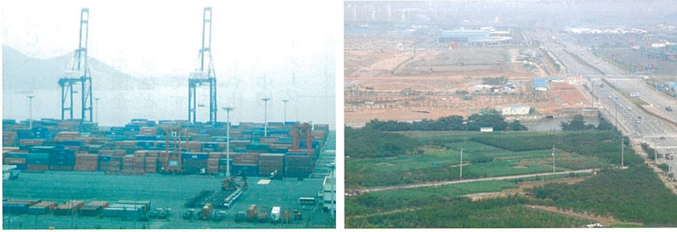
写真2 光陽港の開発状況
