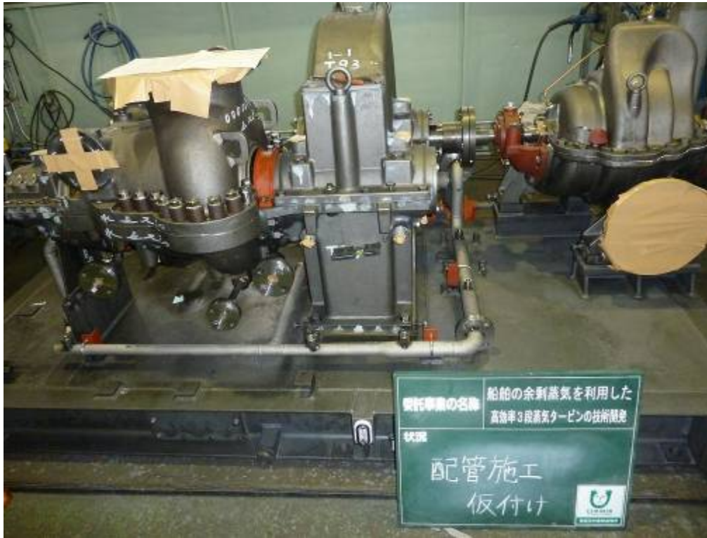
図 4-44 配管施工 (LO 配管仮付け)
