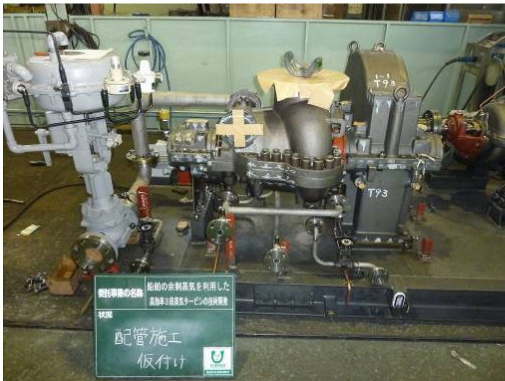
図 4-45 配管施工 (蒸気配管仮付け)
