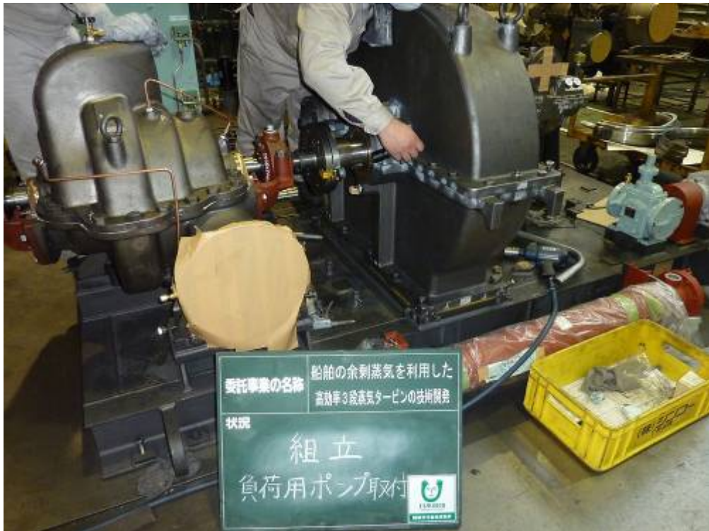
図 4-42 負荷用ポンプ取り付け
