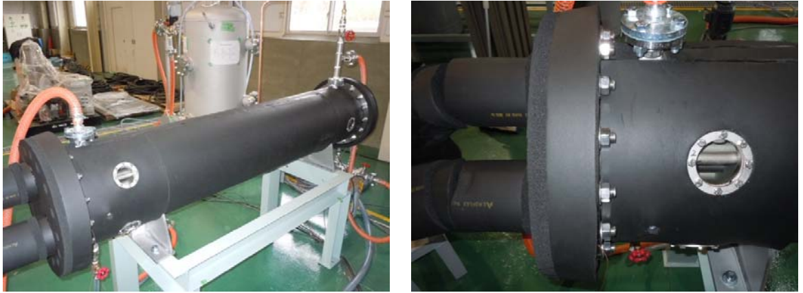
図 4.1.13 防熱施工後の熱交換器
