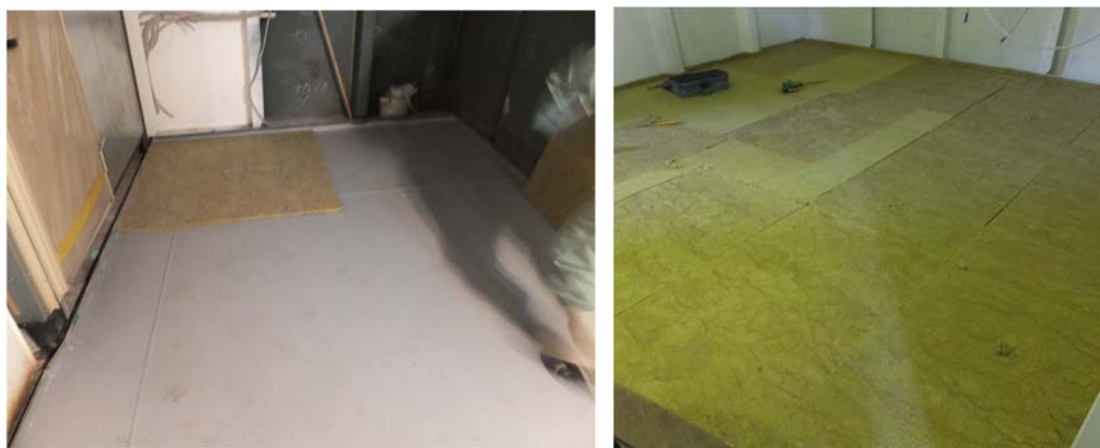
写真 3.5-1 ロックウールの敷き詰め
