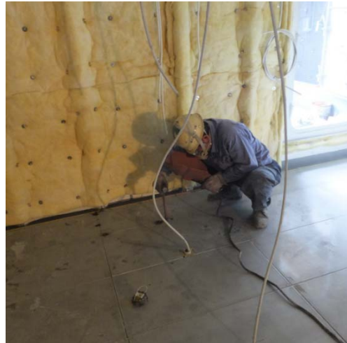
写真 3.4-3 エコライフ S 継ぎ目のタップ溶接
