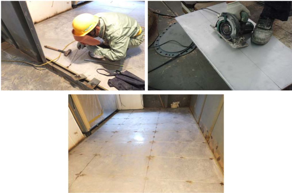
写真 3.5-2 2層目エコライフ S 敷き詰め作業
