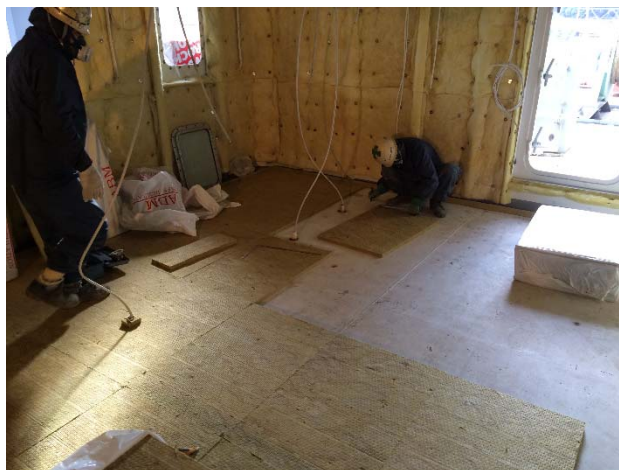
写真 3.4-1 ロックウールの敷き詰め
