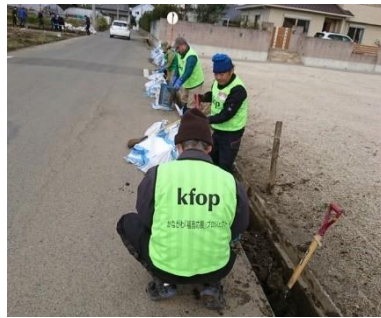
20191129 福島 117 便 (台風 19 号復旧支援 3 号) いわき市
