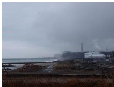
20150411 福島 48 便 (富岡町視察研修：減容施設)
