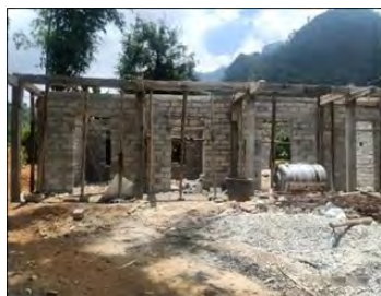
建設途中の小学校建物
