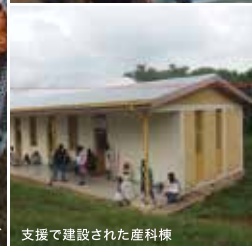
支援で建設された産科棟
