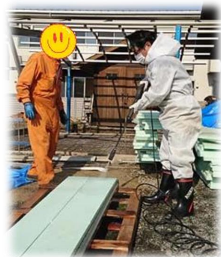
水害で汚れた断熱材を洗浄
