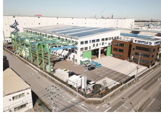
第二工場 2020年3月施工
