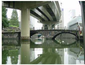
建造されて130年経つ常磐橋
