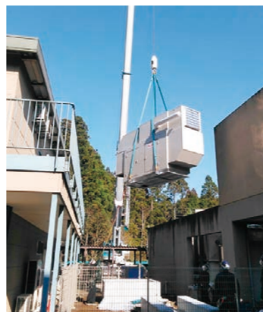
大型クレーンを使って非常用発電機を設置する作業。（杜の家くりもと 2020年12月8日撮影）
