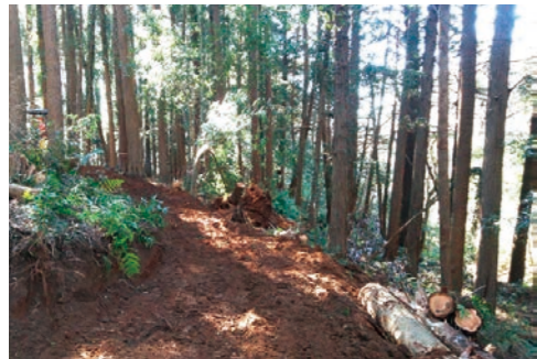
整備した幅員2.5mの作業道。軽トラックが走行できる。道があることで森林の保全活動や間伐材の搬出がしやすくなる。
