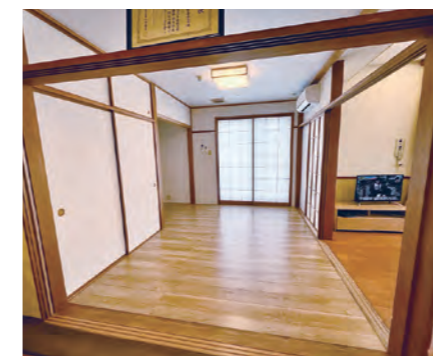
ほぼすべてのユニットの和室をフローリングに改修した。
