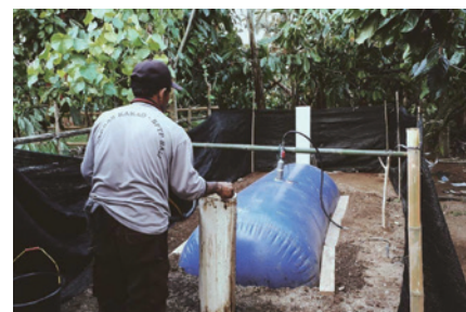
バイオガスダイジェスターに廃棄物を投入し、ガスを生成する
