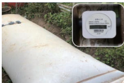
バイオガスダイジェスターとフローメーター
