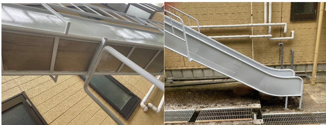
▲錆止め塗装後 (内面・外面・底面裏・手すり・脚部・ステンレス部を除く)
