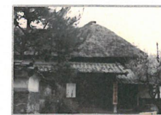
「旧田澤邸」解体 昭和58年(1983年)10月4日
