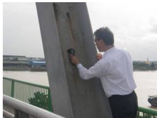
エーヤワディ地域 鋼橋塗装調査 (外務省 NGO 補助調査 2011/6)
