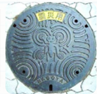
下水道直結式仮設トイレ
