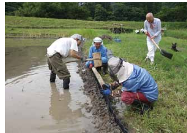
土木作業でもある
