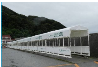
風雨防通路シェルター
