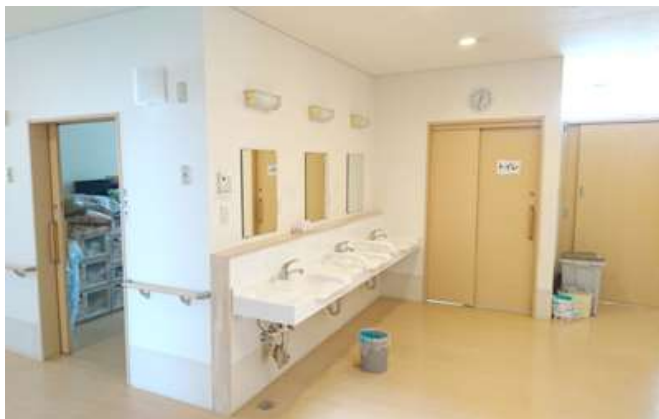
居室側洗面所
