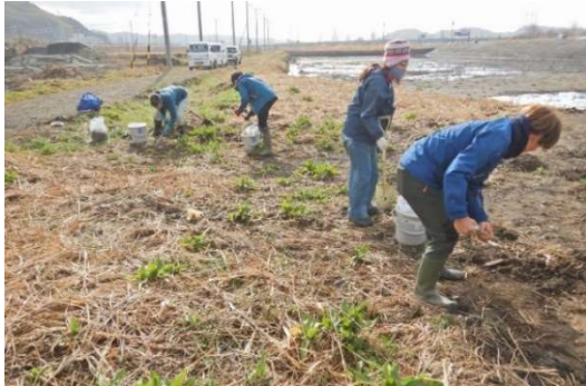
写真 5.1 遊水地工事個所の表土を採取
