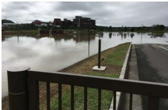
写真 7.6.1 あさはた緑地出水状況
