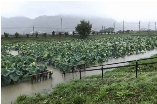
写真 7.4.1 遊水地出水状況
