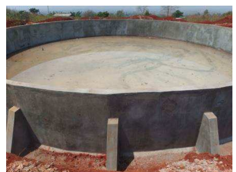
シーサイン水タンク建設
