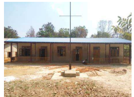
完成したカウントー小学校
