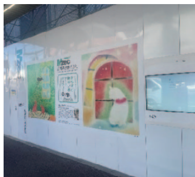
馬淵建設株式会社様 【建設現場仮囲い (東京都中野区)】
