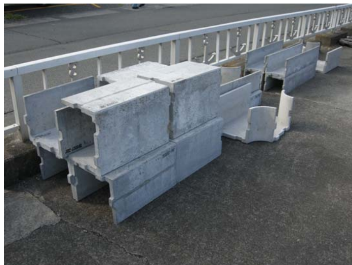
写真 24. コンクリート製U字溝「ケーブルトラフ」
