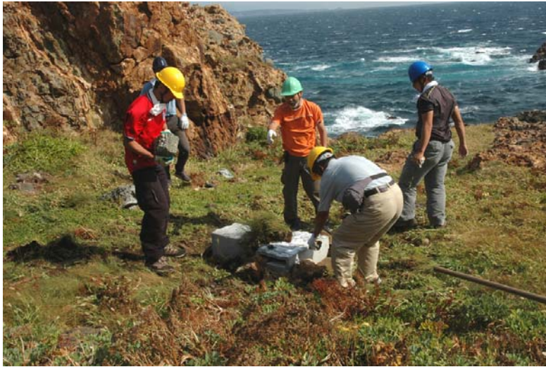
写真 25. 設置作業の様子
