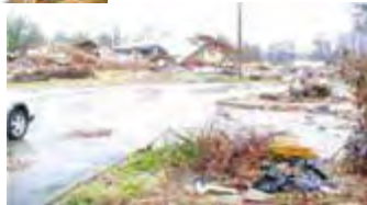
海岸近くの民家の破壊
