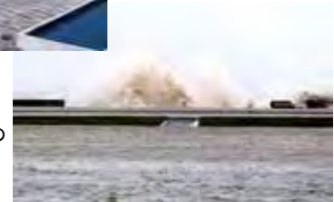
山口宇部空港の 護岸被災
