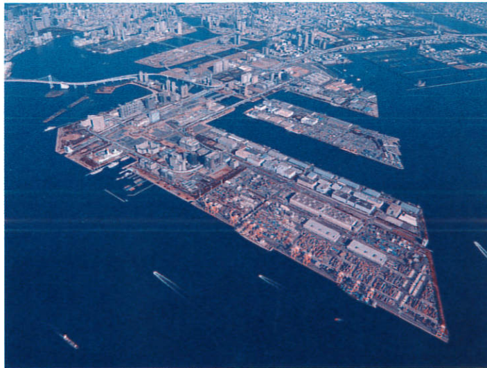
▲コンテナ貨物の荷さばき、保管施設がそろう青海コンテナふ頭 (写真提供) 東京都港湾局
