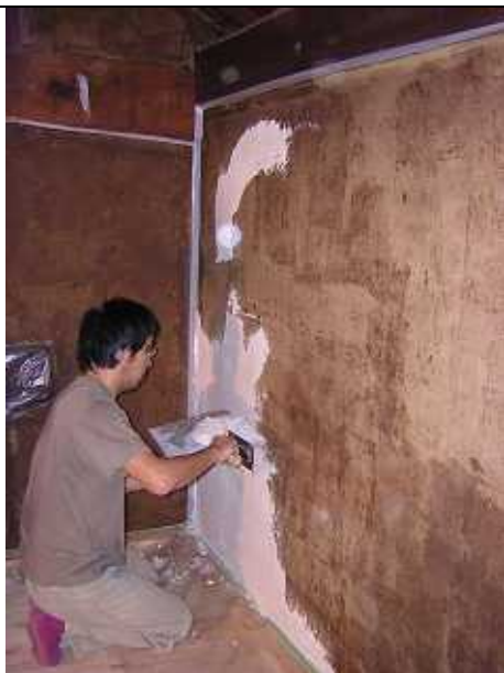
屋根裏部屋を改装して居室に
