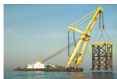
Sheerlegs Crane/ Pull Barge SADAF 3000
