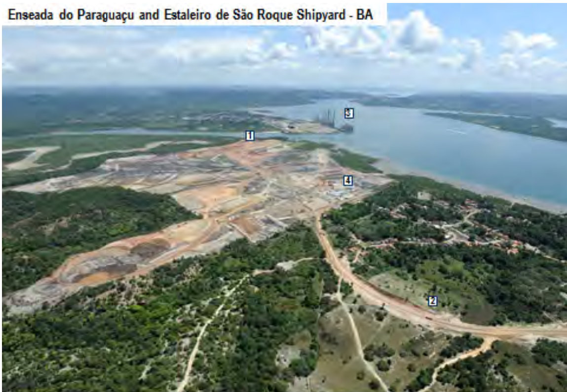
Overview of Future Estaleiro Enseada do Paraguaçu Area in Maragogipe - BA and the Estaleiro São Roque do Paraguaçu at the second view, the margins of Rio Paraguaçu (03/00/12). The estaleiro Enseada do Paraguaçu has contract with Setebresil to build the 6 DRILL SHIPS (Drillme, Pitões, Solpebs, Interlagos, Itapema, Comendatubos). (1) Rio Paraguaçu; (2) Access Road; (3) Estaleiro de São Roque - P50 and P60; (4) work gantry of Estaleiro Enseada do Paraguaçu.
