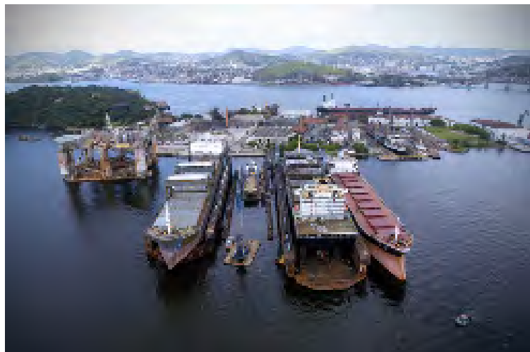
造船所全景：海洋構造物や大型船の工事も実施
