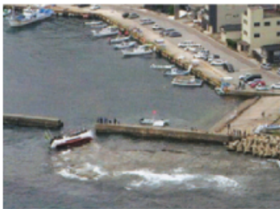
乗り上げ船現場の状況
