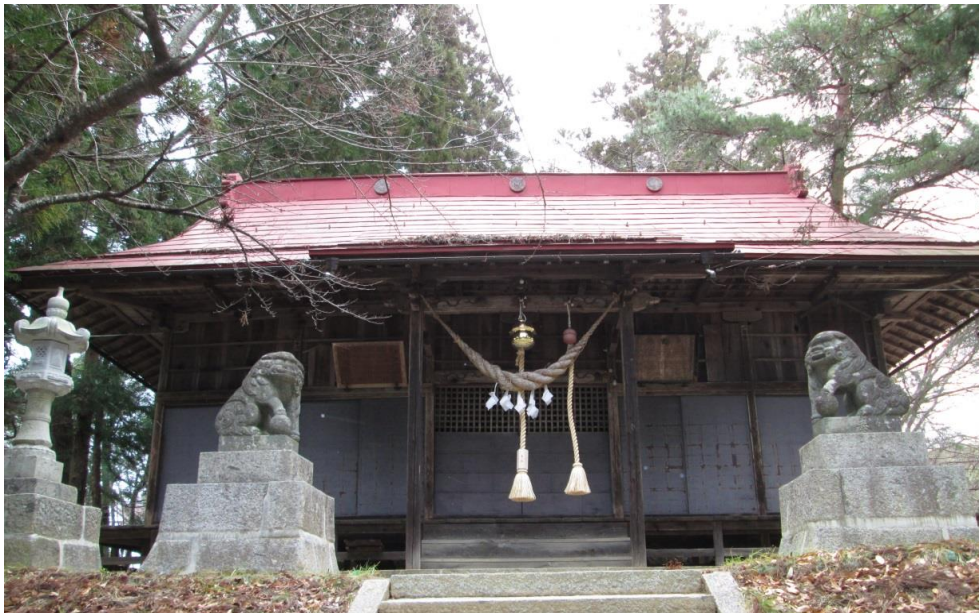
○平成28年12月23日、神社再建工事竣工の写真(拝殿正面)
