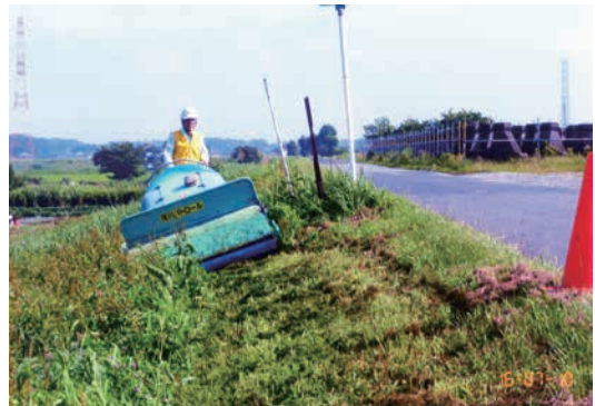
▲堤防除草作業
