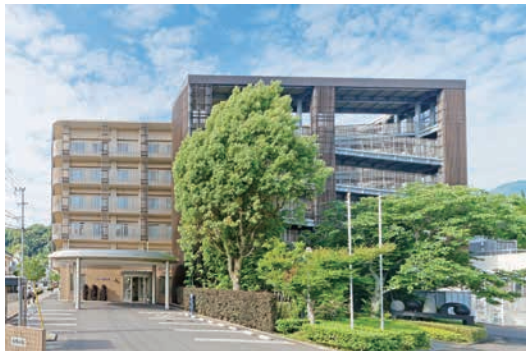
▲太陽の家本館（2011年完成）
