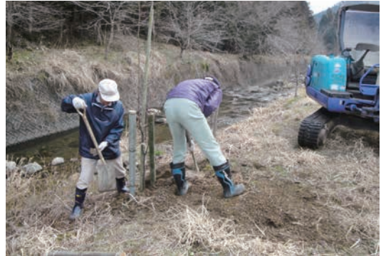
▲ 機材も持ち寄っての作業
