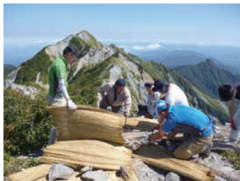
▲コモ伏せ作業 植物の根付を良くする
