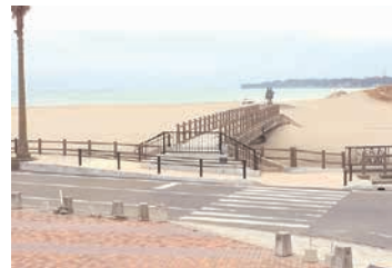
▲海岸遊歩道の35センチの段差がなくなる（町役場提供）
