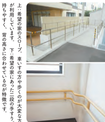
上：希望の家のスロープ。車いすの方や歩くのが大変な方が利用しています。下：希望の家にあった二段の手すり。持ちやすく、背の高さに合わせているのが特徴です。
