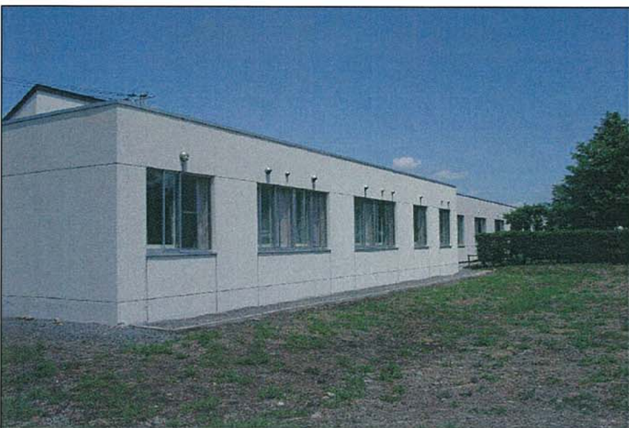
位置： 1工区外壁 撮影日： 平成22年4月20日
