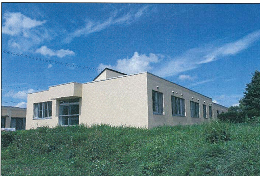
tt 1工区 撮影日： 平成22年7月31日 改修完了
