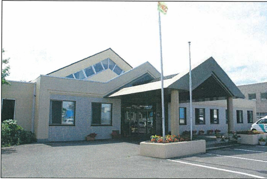
位置： 正面玄関 撮影日： 平成22年7月31日 改修完了
