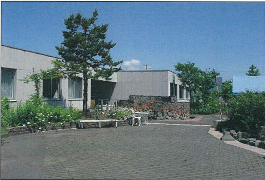
位置： 中庭 撮影日： 平成22年4月20日
