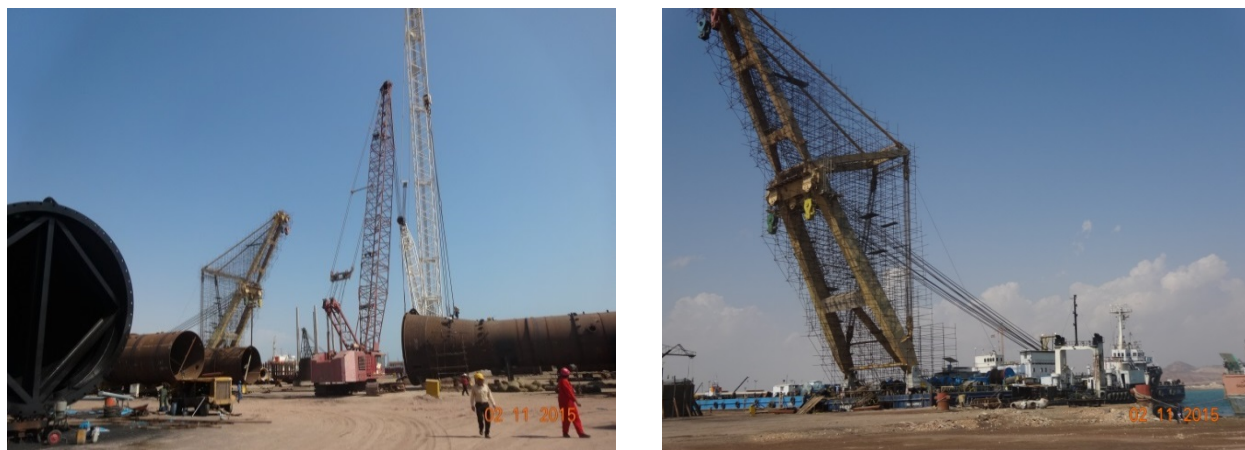
図 3- 7 SAFF Offshore Industries Co.で建造されている石油ガス関連のプラント構築物（左）と吊能力 3000 トンのクレーン船（右）（2015 年 11 月）
