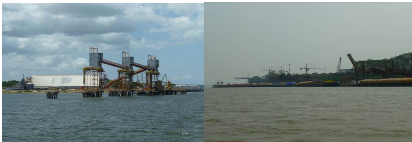
左. パラー州サンタレン積出施設 右. ロンドニア州ポルト・ヴェーリョ積出港
