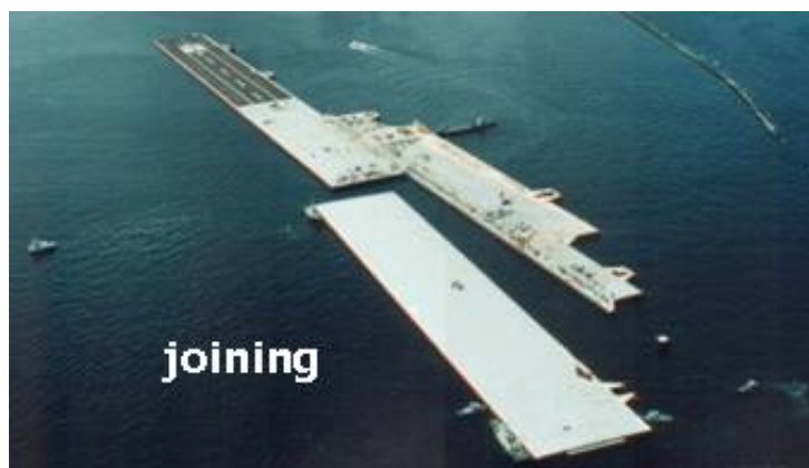
浮体ユニットを洋上で溶接接合
