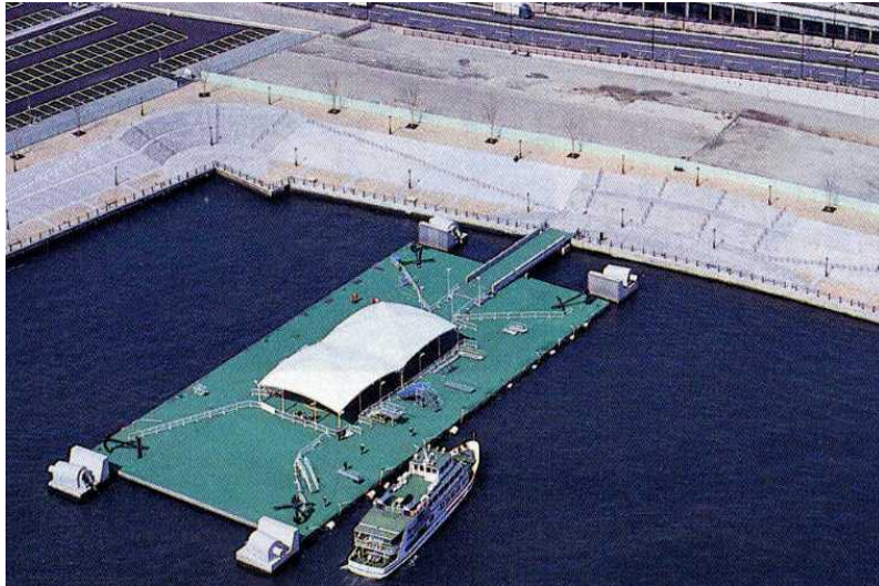
図 37 大阪湾（大阪）に設置された浮体式防災基地
