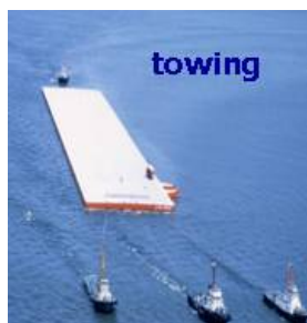
浮体ユニットを建設現地に曳航
