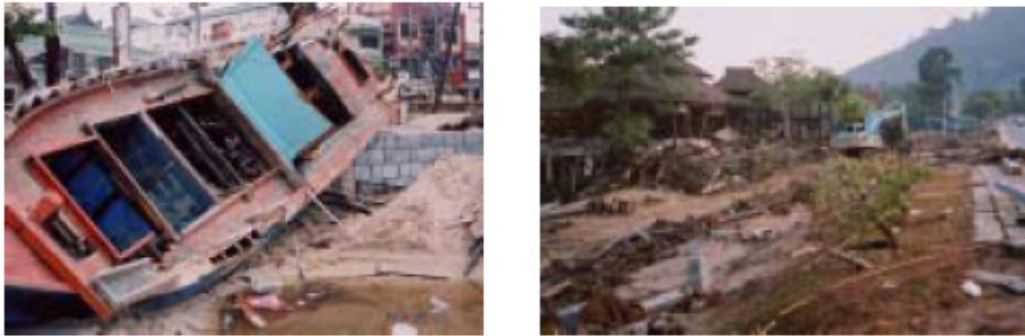
図 19 プーケット島バトンビーチに打ち上げられた船(左)と壊滅的被害を受けたカオラックリゾート (右)
