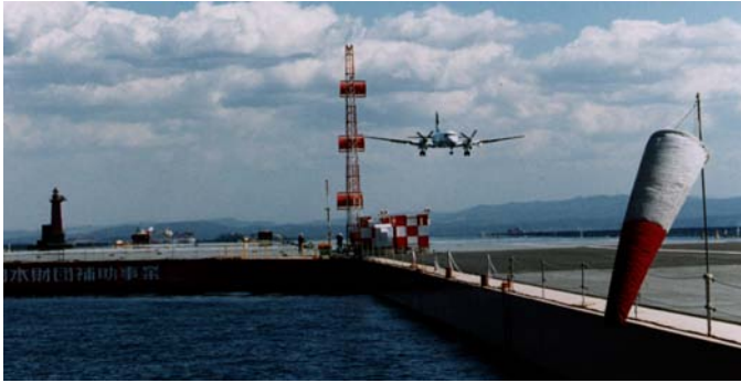
1000m浮体空港モデルへ航空機進入試験
