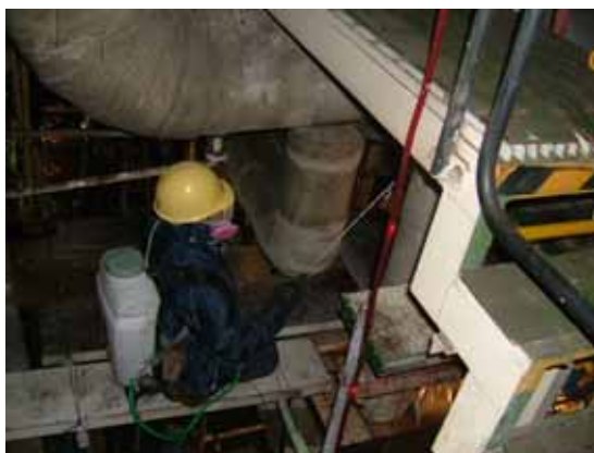
(噴霧器を使用してのアスベストの湿潤作業中)
