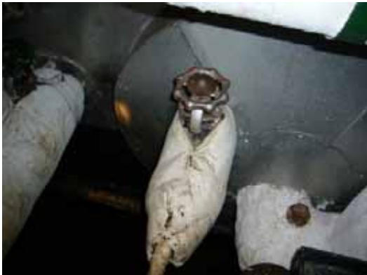
(蒸気弁に使用のアスベスト布団)
